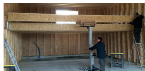
BD 1 mit wood beam 180 kg - 7 m Length
